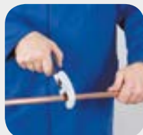
1. Rohr ablängen.
